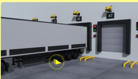
Após o estacionamento adequado e o assentamento do calço ou do hidráulico de bloqueio, o TRUE-AI fornece os impulsos relacionados para abrir as portas para o acesso do camião.
